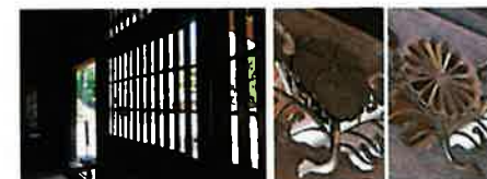
左：蔭戸。昼間は光を採り入れ、夜は閉めて雨戸にすることができる。右：家紋の透かし彫りが施された欄間。下：仏間。坂野家でもっとも古い部分で、客間としても使用されていた部屋
