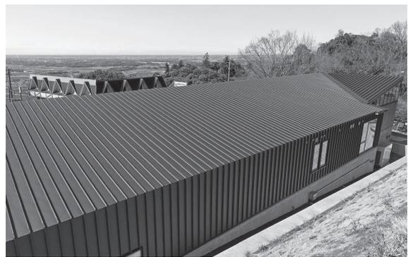
敷地が斜めのため、全体的には高床構造となっており、1階では全面的にRCスラブとして建物の一体性を確保した。トイレ下層では機械室が計画された壁式鉄筋コンクリート造となっている。
