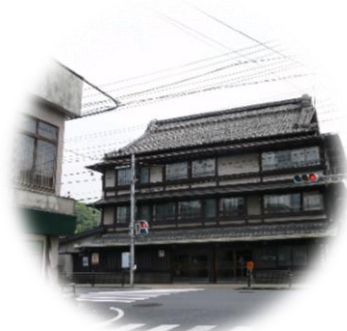
改修前の井筒屋 曳家(ひきや)をして建物の位置を奥にして、改修を行いました。
