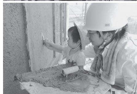
小舞下地に土壁を塗る。大人も子供も夢中で作業。
