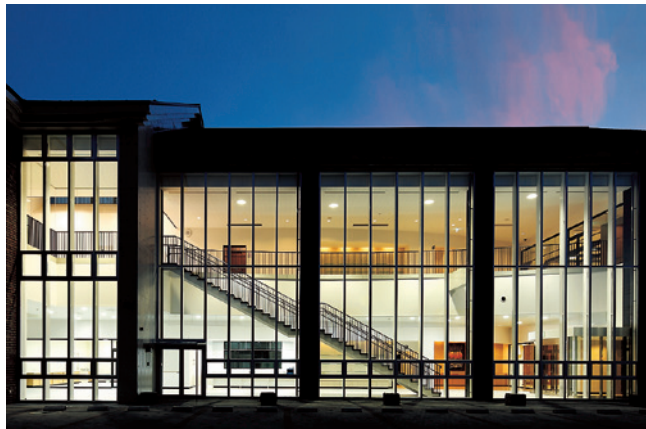
古河市地域交流センター「はなももプラザ」(夕景)
