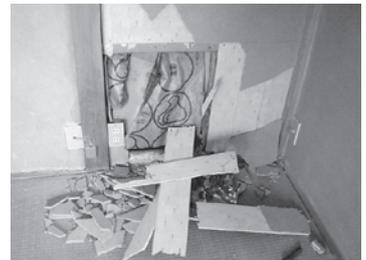
にひびが入る被害があった。上屋の揺れによりアンカーボルトに大きな力が加わって破壊したものと思われる。家の中では筋交い周囲の壁のひび割れが多く、家具類の転倒が激しかった模様。しかしながら、近隣に建つ、基礎と一体となっていない土台や、筋交いを持たない工法で建てられた住宅（いわゆる在来軸組工法、伝統工法）は、土台のずれが認められるものの、家屋の被害は極めて少ない。このような被害傾向は他の場所でも確認された。地盤と一体となって地震の力を全て上部の建家に伝えてしまう耐震の考えと、地震力を基礎部分で低減し、建物全体で地震力に抵抗させようとする考えの違いであるが、地盤と基礎に緊結する現行基準によって建てられた木造建築物が、必ずしも在来の軸組工法に勝るものではないと思われる。むしろ、在来工法の優れた考えをもっと生かした基準の見直しを考えるべきである。『地震に強い建物』（剛構造）より『地震になじむ建物』（柔構造）を…
