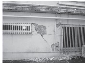
耐震判定指標値」の小さい建物でも、地盤や地震加力方向により被災の程度が違うが、コンクリート強度が比較的大きな建物の被害が少ないように思える。
