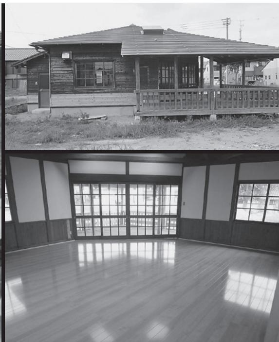
「県営日の出住宅」集会所の復旧工事見学会には、300人が参加。土台から上をジャッキアップ後、コンクリートを充填して基礎天端を嵩上げた。
