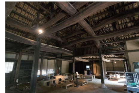
上：主屋の土間部分。見上げると、太い梁を組み合わせた力強い小屋組みが確認できる。また、竈（かまど）は、大小合わせて4つが設置されており、往時の使用人の多さを伺わせる。
