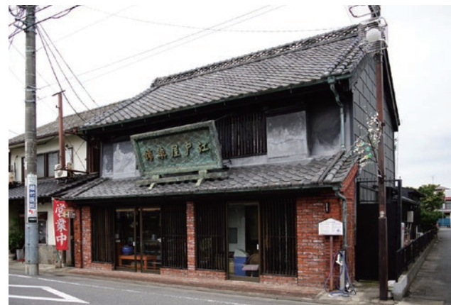
土壁と煉瓦積みの組み合わせが独特の存在感を放つ。煉瓦を斜めに組み合わせるなど積み方もユニーク
