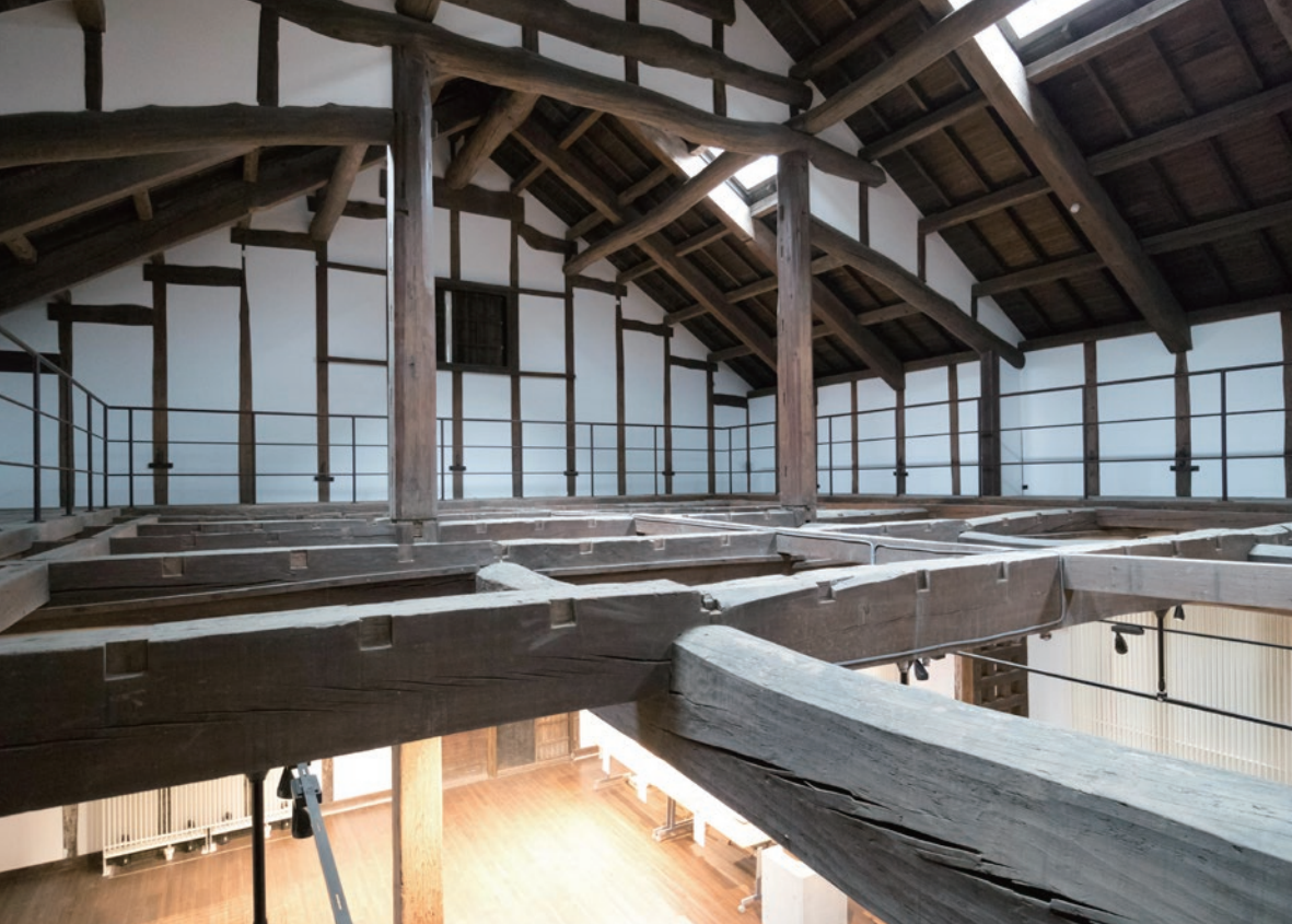
かつて酒造の本蔵であった建物は、梁組みを生かした「展示施設」へと改修された
