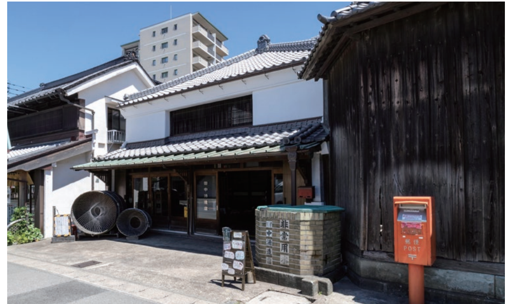
店舗外観。店舗の裏手の広い敷地に醸造蔵がある。写真中央に見えるのが天水桶
