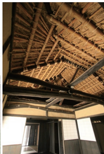
茅葺屋根を中から見上げたところ
