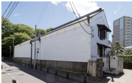
関東大震災、東日本大震災の2度の震災に耐えた蔵
