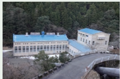
国の重要文化財に指定されている石岡第一発電所
