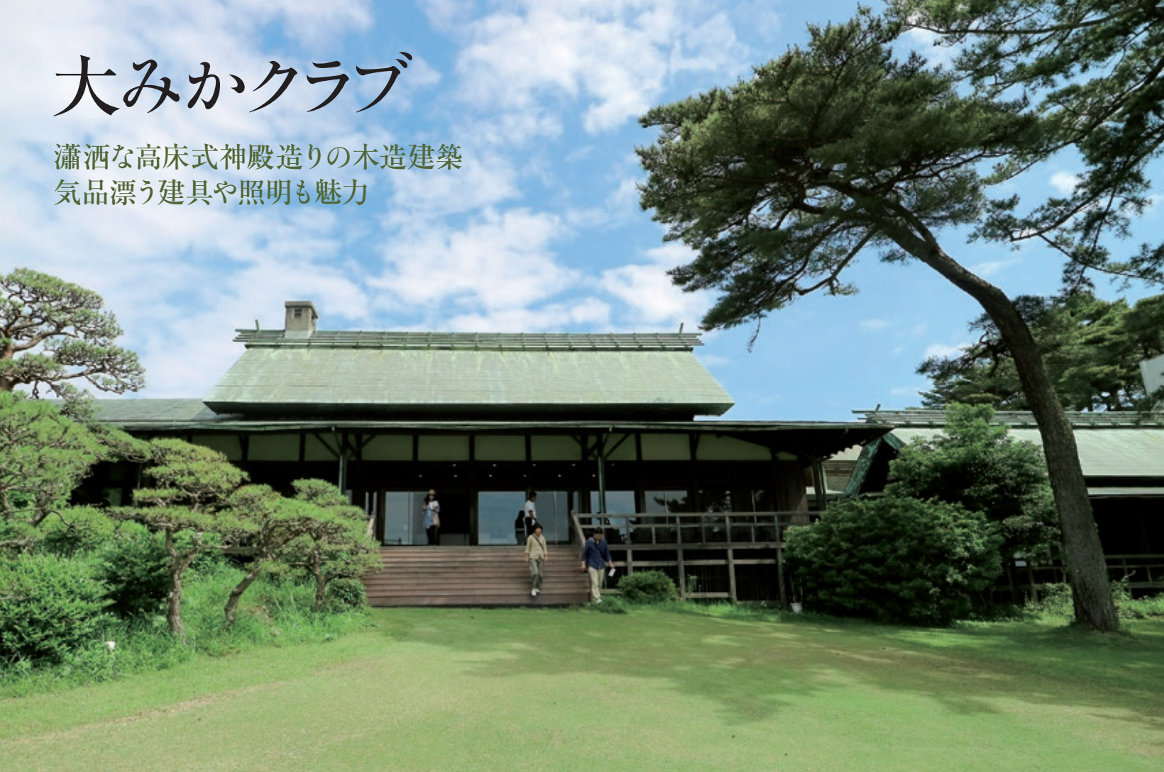
左：ゴルフコース側からみたクラブハウス。敷地の傾斜を生かした高床式の構造がよくわかる 上：銅板葺きの品格ある切り妻屋根
