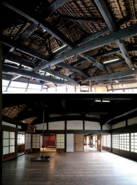
上：天井には松丸太の迫力の小屋組み／下：土間から上がった広間
