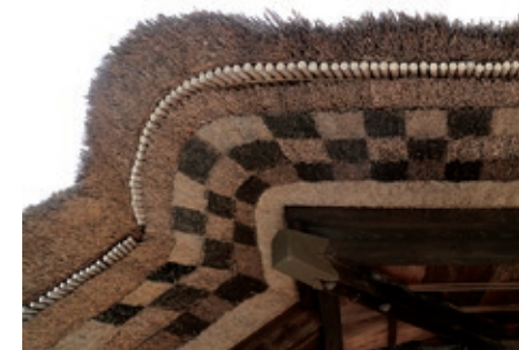
「五段茅葺中竹節揃角市松模様寄棟造り」の軒付け
