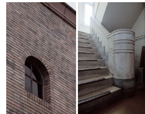
スクラッチ模様入りのタイルと一部残るスチール製の窓枠 地元で採れた大理石(寒水石)を贅沢に使った階段室
