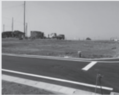
▲一部舗装工事了
