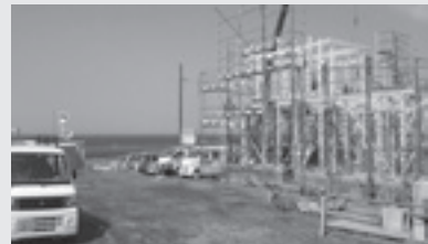
▲復興住宅 2 棟目の建築 軒裏を設けない建築物を推進
