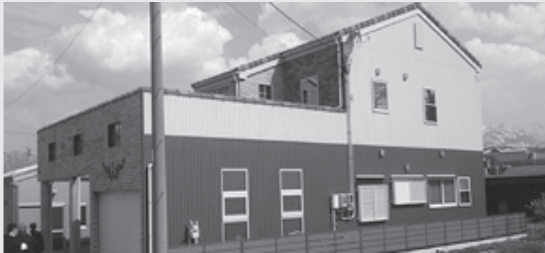
▲被災後、条例改正等行い、最初に建てられた店舗併用住宅 延焼防止のため、軒先、ケラバ等、軒裏を設けない建築様式として建てられた店舗併用住宅 勿論、使用材料についても防火材を指定
