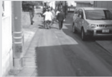
▲被災地はこのような道路幅員 4m 未満の町並みが続き、消火活動に支障を来し、被害を拡大してしまった
