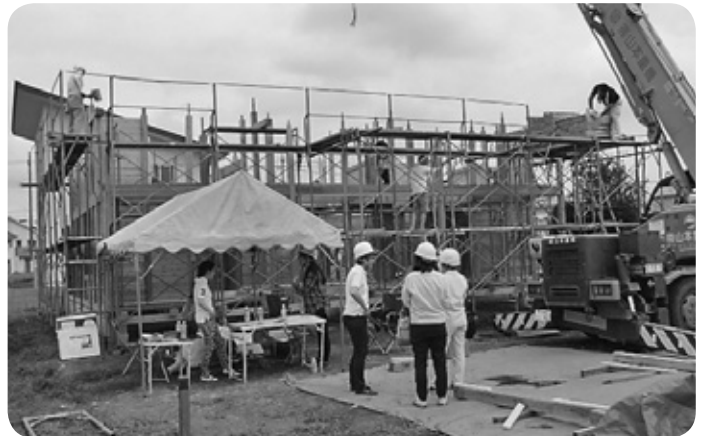
伝統的な木造建築工法「板倉構法」で建築中の住宅を見学
