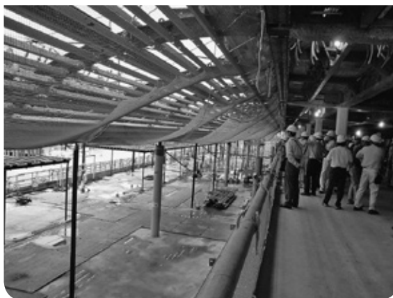
平成29年度中に供用開始予定で工事が進む日立市新庁舎
