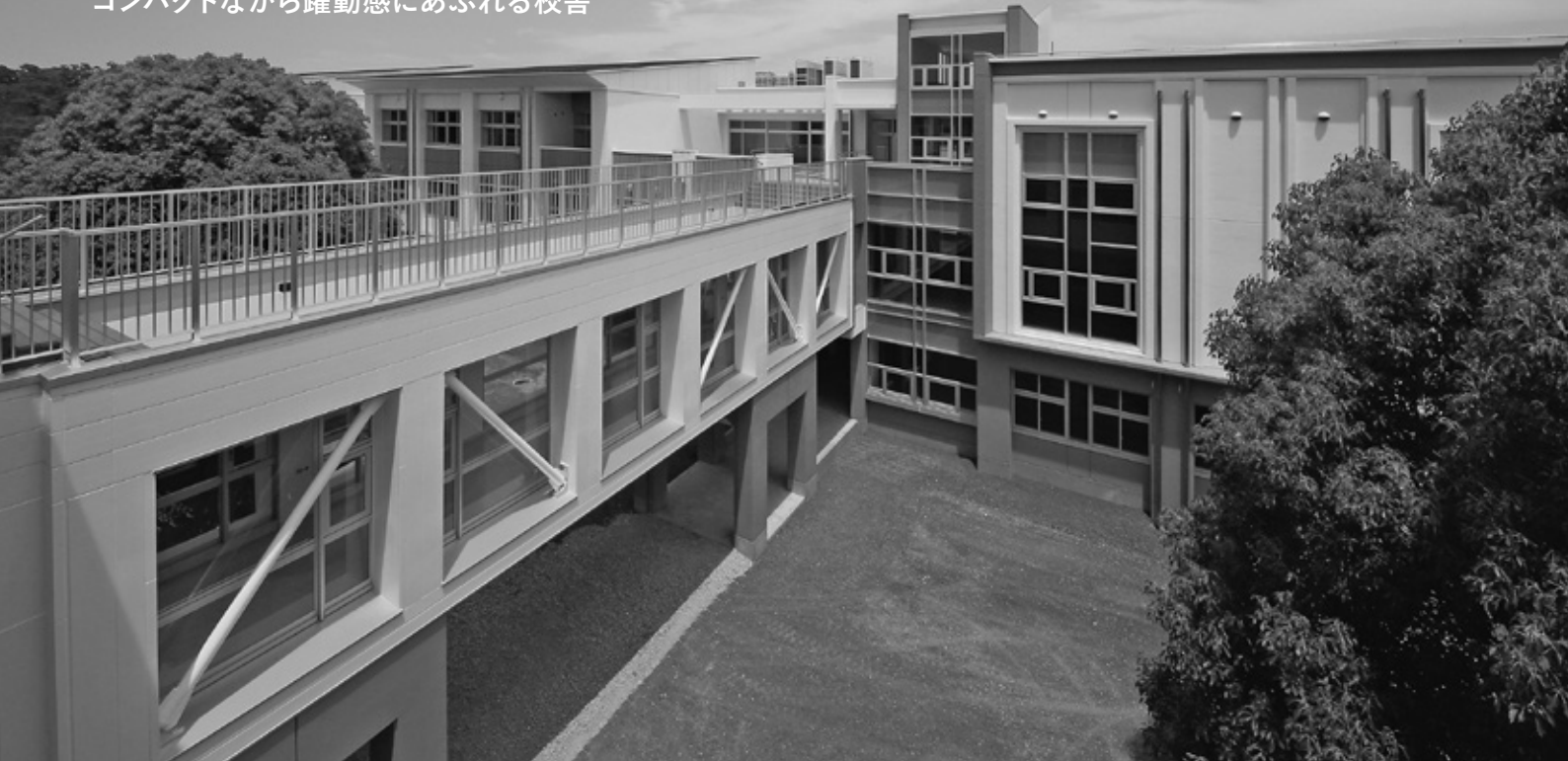
南側外観 撮影：アートフォトTANII：谷井修二
