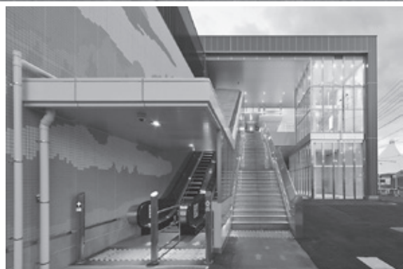
写真上：北西側からの外観／下：西口階段
