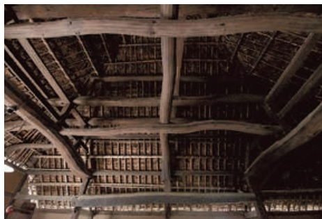
曲がり材が特徴の迫力ある梁組み
