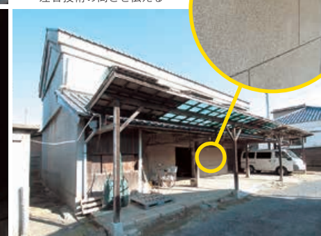
昭和初期に建設された穀蔵。美しい「洗い出し仕上げ」が左官技術の高さを伝える
