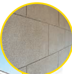
昭和初期に建設された穀蔵。美しい「洗い出し仕上げ」が左官技術の高さを伝える
