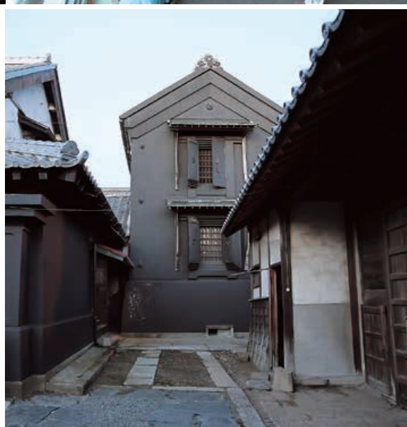
主屋の北方に建つ黒漆喰塗りの文庫蔵。外から見ると2階建に見えるが、内部は3階建の土蔵造
