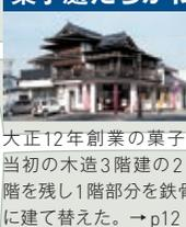
大正12年創業の菓子店。当初の木造3階建の2~3階を残し1階部分を鉄骨造に建て替えた。→p12
