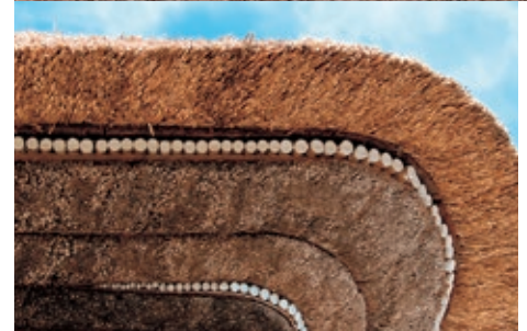
上:「煙出し」。大きく「水」の文字が描かれている。白く染めた竹の小口を使った装飾も/下:軒にも同様の繊細な飾りがみられる
