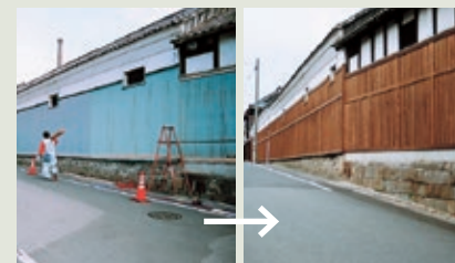
修景前：トタン板塀
