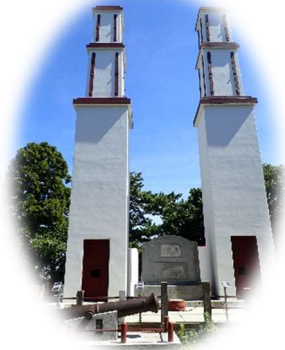
反射炉跡 山上門をくぐると、 高さ約 15mの四角い煙突が見えてきます
