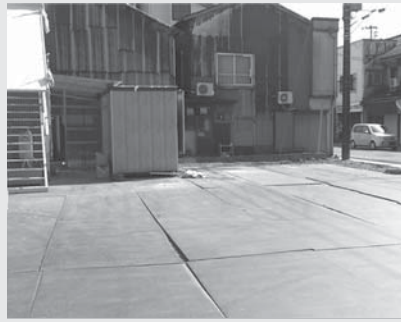
▲火元となったラーメン店(プレファブが置かれている)(写真上)
