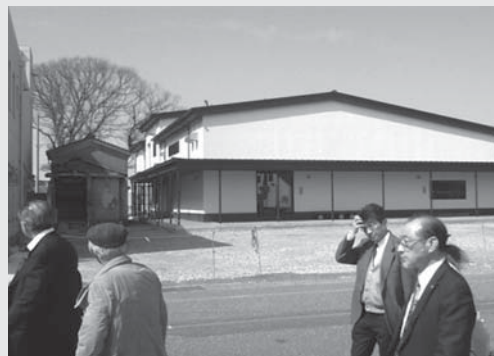
▲以前の面影は無く再建され操業開始している、加賀の井酒造準防火地域であり、何度となく、大火に見舞われた糸魚川市条例に伴い建築された。酒蔵内部の様子を外から見学出来るようのぞき窓が設置された。「近代的な酒蔵に生まれ変わった」※復旧復興計画等詳細について次号に続く
